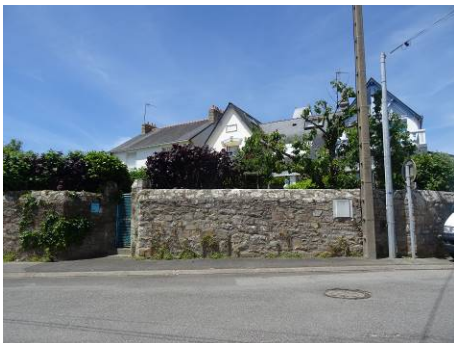
Mur de clôture en pierre à couronnement triangulaire. Rue du Verger.
