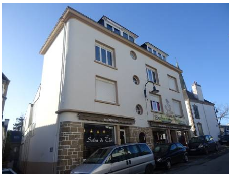
Rue du Tumulus, venelle des Forges. Immeuble des années 1920-1930 influencé par le style « paquebot » de par sa demi-travée centrale de jours d'escalier en forme de Hublots.
