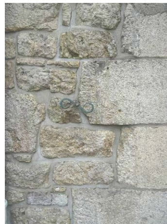
Détail de la façade du 10, place de l'Eglise.
