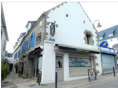
Maison 1, place de la Chapelle (p. 641). Petite maison du 17 e siècle refaçadée au 19 e siècle.
