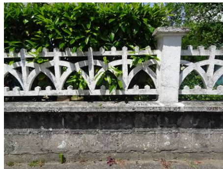
Mur de clôture à claire-voie (parpaings de mâchefer et béton armé). 6, rue du Verger. Vers 1920-30 ?
