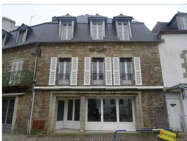
L'ancien Hôtel des Voyageurs, 19 e siècle. Place de l'Eglise. 2016. Le percement du rez-de-chaussée au 20 e siècle a déséquilibré la composition de la façade.
