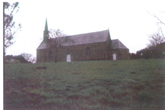
Photographie du site.
