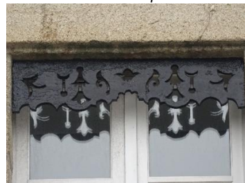
Place de l'Eglise. Les décors en bois découpé (lambrequins) font partie du vocabulaire typé de l'architecture balnéaire.
