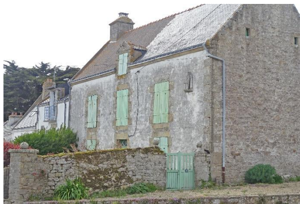
L'enclos de mur plein fait partie de la composition architecturale de cette belle maison à Bourgerel.
