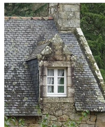
Gouyandeur Lucarne à deux pans et fronton triangulaire.
