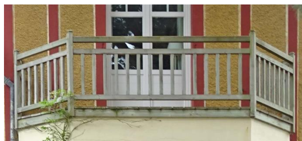
Carnac-Plage, allée de Kermario, villa Ker Lois. Le balcon à claire-voie peut se présenter sous la forme de simples barreaudages verticaux entre des lisses.
