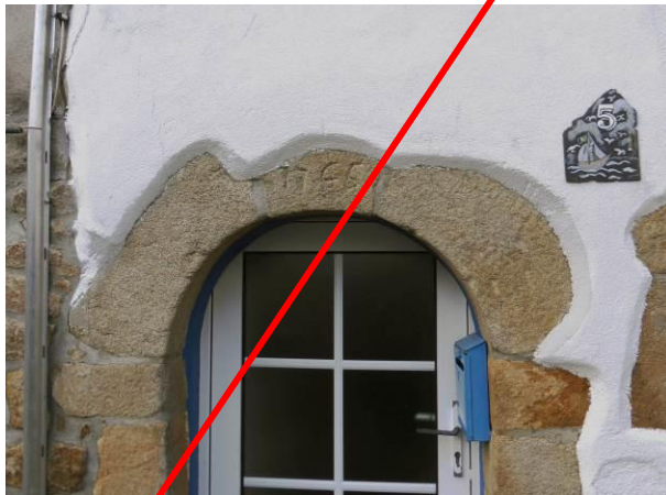
Ci-dessus, l'enduit a été appliqué en épaisseur et présente un fort relief par rapport au nu de la pierre apparente
