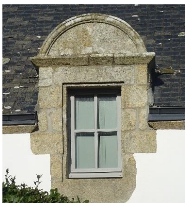
Saint-Colamban Lucarne passante rurale à deux pans et fronton en demi-lune..
