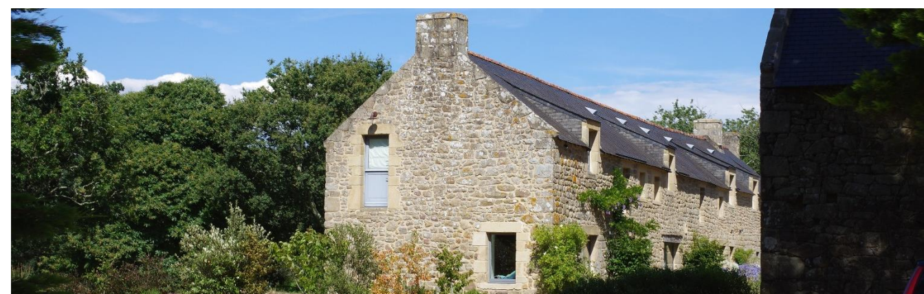
Ferme de Kergléverit (Crac'h) à l'architecture caractéristique du territoire
