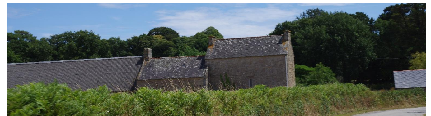
Architecture typique des bâtiments d'exploitation du 19ème siècle s'insérant dans le bocage (au lieu-dit Le Lizo à Carnac)
