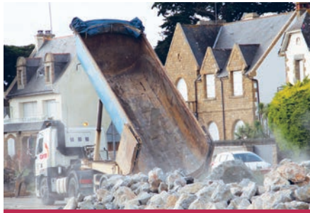
Travaux de renforcement du trait de côte
